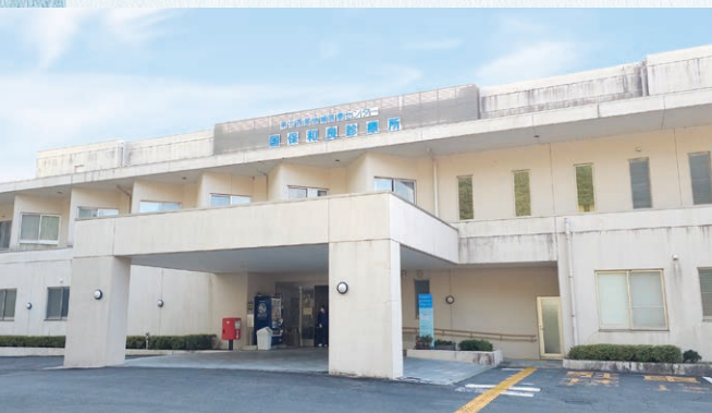
県北西部地域医療センター 国保和良診療所 岐阜県郡上市和良町沢 882 番地
