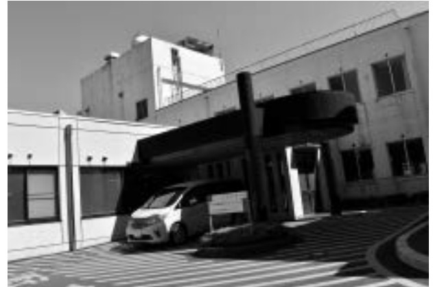
写真21 診療棟と保健センターを併設
