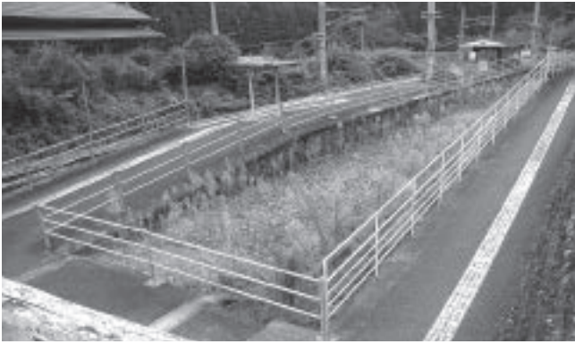
写真2 無人駅の点字ブロックと手すり付きスロープ
