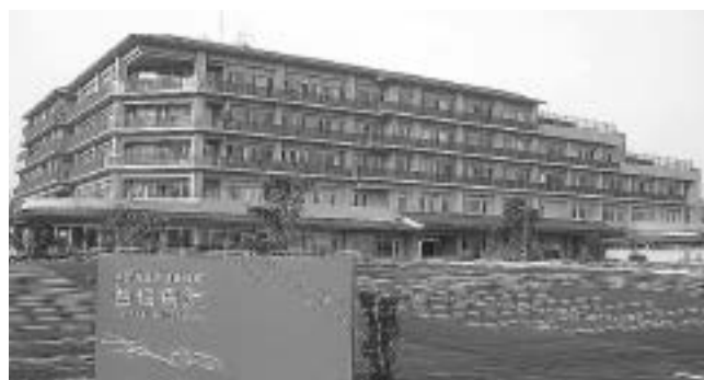
写真 病院外観
