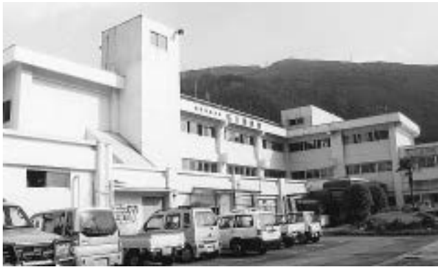
写真2 改築前の古びた建物
