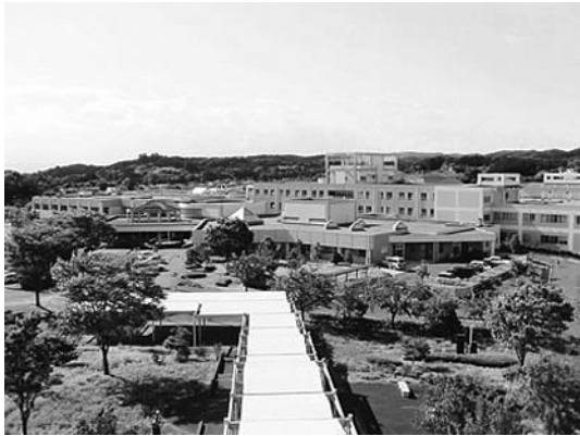
写真2 涌谷町町民医療福祉センター全景
