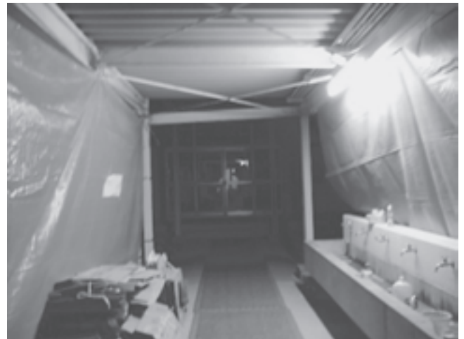
放射能よけのブルーシートを張った（石神第一小学校）
