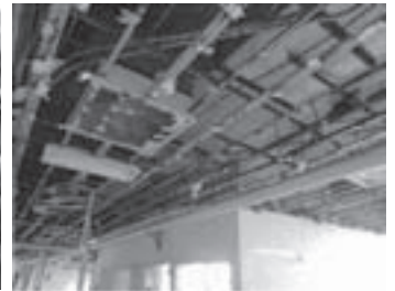
津波で吹き飛んだ公立志津川病院4階の天井
