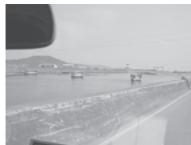
津波で流された気仙大橋
