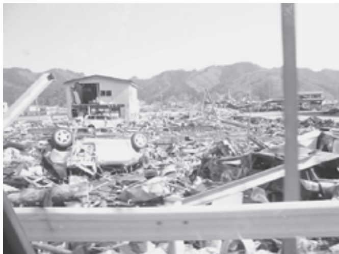
津波による被害
