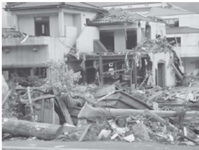
津波による被害
