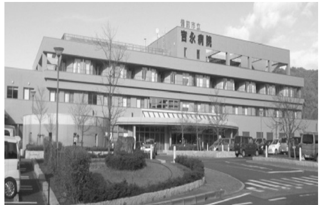
写真 病院外観
