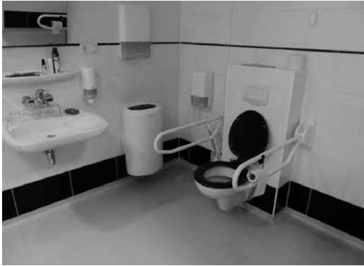
写真17 ヘットゾネハウス内のリハビリテーションセンター入所者用のトイレと洗面所
